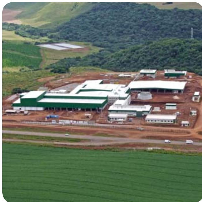
Imagem aérea da Unidade de Processamento de Suínos
