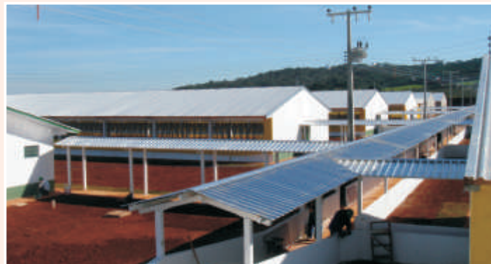
Fase de conclusão a nova Granja dos Pinheiros
